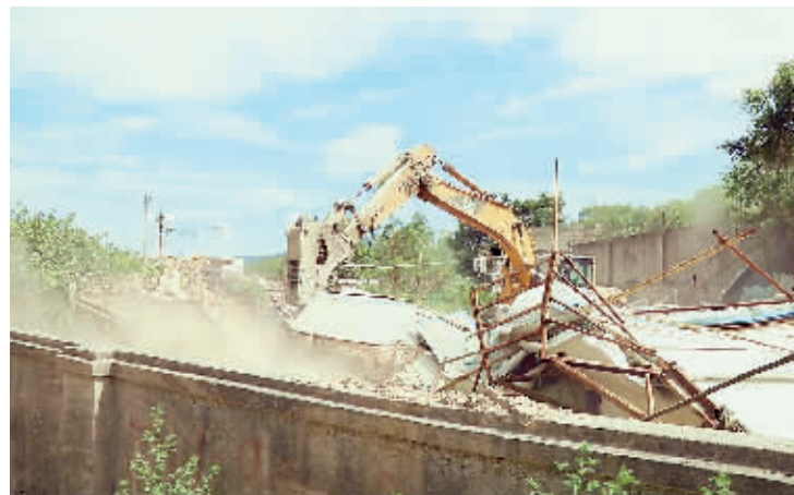
内厝镇小光山矿区一企业违建管理房被拆。
